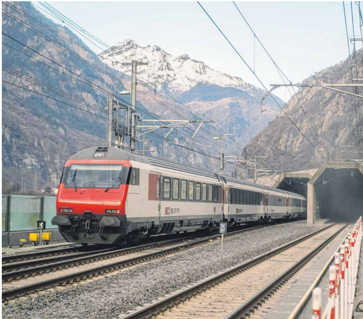
Der südliche Teil des Gotthard-Basistunnels in Pollegio, Schweiz. Zum Unmut der Eidgenossen kommen die Deutschen ihren Ausbaupflichten nicht nach.
